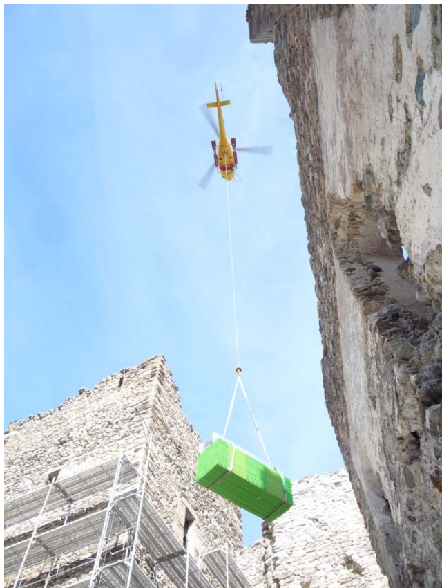
Fig.: AS 350B3e Heli Bernina AG con TLDS+_14_30 (WLL 14 kN). Per gentile concessione della Heli Bernina AG
