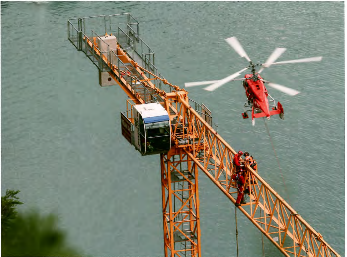
Müssen den hohen Anforderungen kompromisslos genügen: Die persönliche Schutzausrüstung gegen Absturz der Flughelfer und die Lastaufnahmeeinrichtungen am Helikopter.
