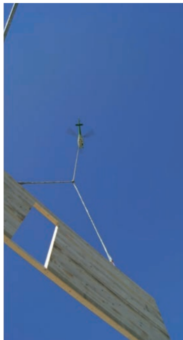
Abb. 1: höchst effizient. Durch die Luft direkt auf die Baustelle und montiert
